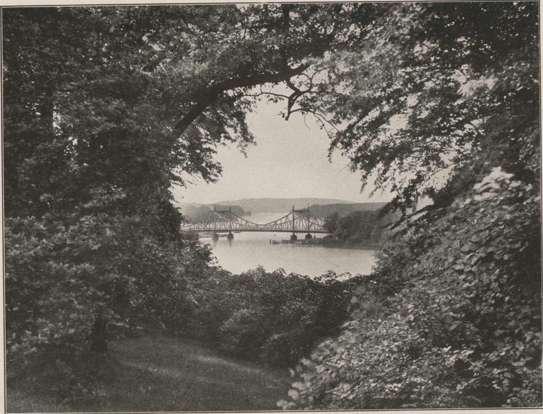
POTSDAM. GLIENICKER BRÜCKE.
