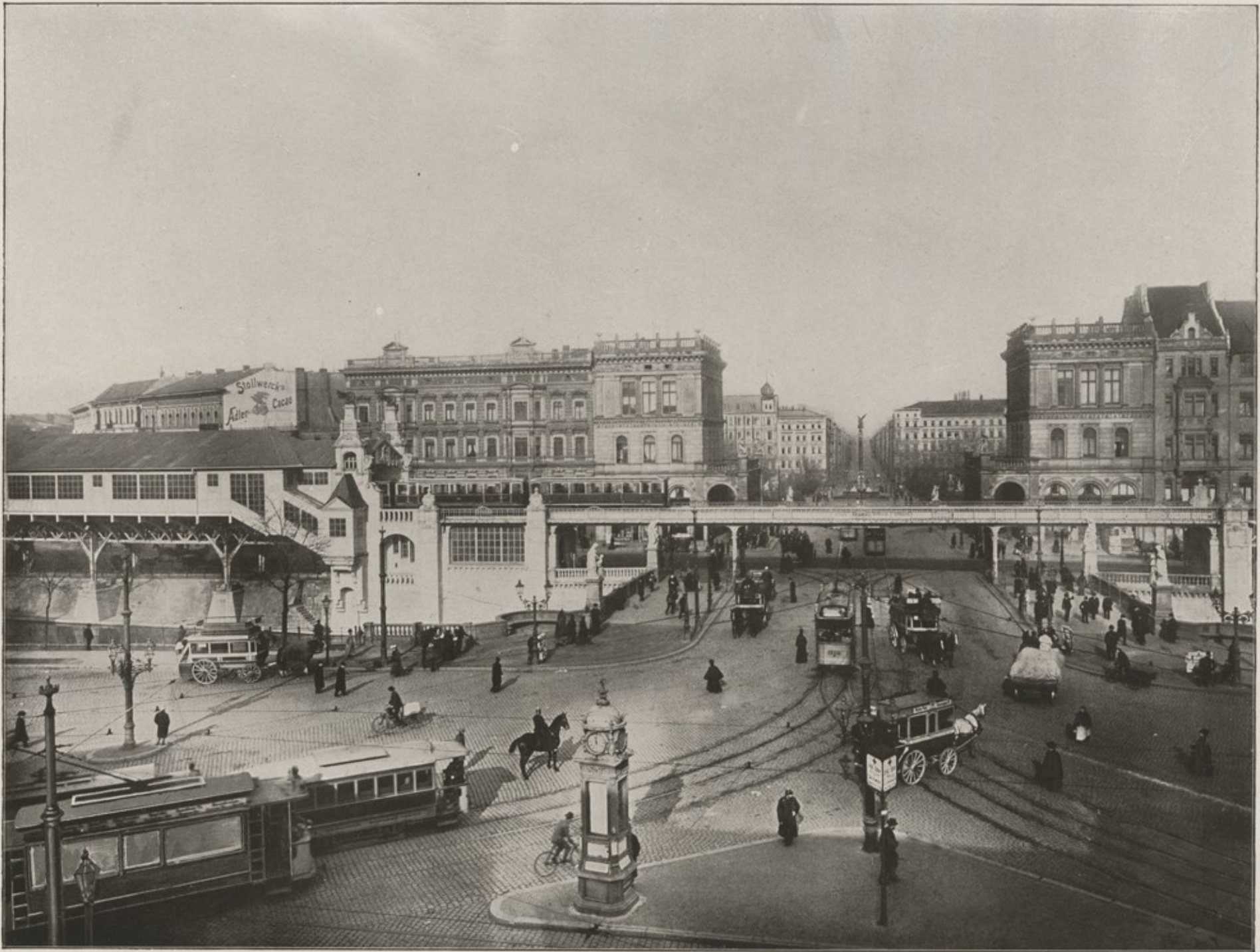
HALLESCHES TOR MIT HOCHBAHN-BAHNHOF.
