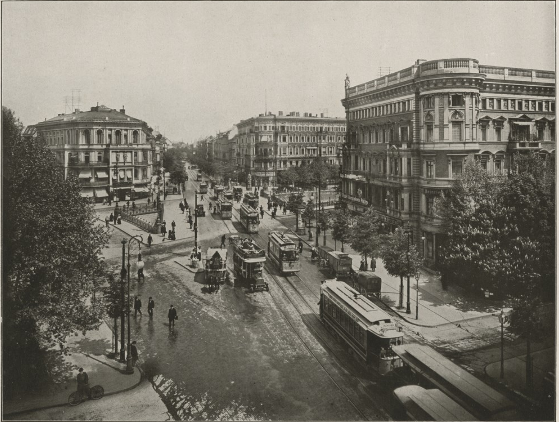
POTSDAMER BRÜCKE UND POTSDAMER STRASSE.
